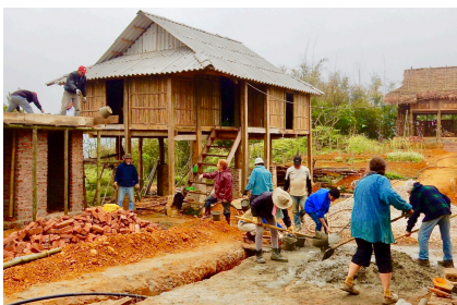
Construction d'une maison pour femmes à PuBin, Vietnam
